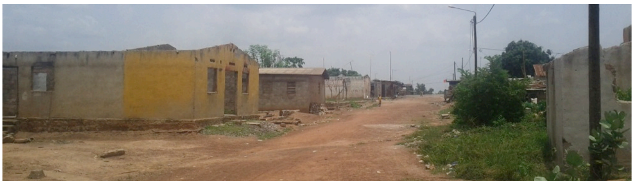
Plusieurs maisons en dur endommagées et abandonnées, quartier Guéré, Doukoué
