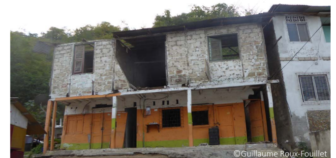
Problemas de estabilidad frente al sismo de los muros de albañilería sustitutos de la caña picada en viviendas de estructura de madera
