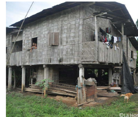
Vivienda de transición en Los Ríos, con materiales tradicionales y hormigón en los pilotes en contacto con el suelo
