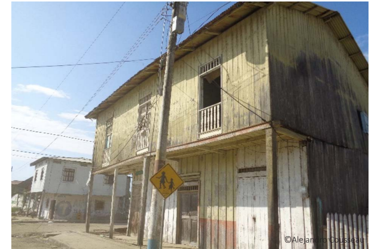
Vivienda tradicional de madera en Jama, habiendo resistido al terremoto. Las viviendas urbanas tradicionales cuentan con soportales, galerías y aleros que evitan el impacto directo del sol en las paredes. Los soportales favorecen la presencia y circulación de personas independientemente del sol o la lluvia ©Alejandro Cousseau
