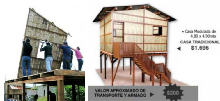
Ejemplo de prototipo de vivienda modular palafítica de bajo costo
