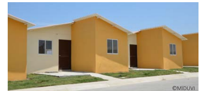
Viviendas del MIDUVI en Manta, con un factor de forma negativo de cara a la resistencia frente a los terremotos
