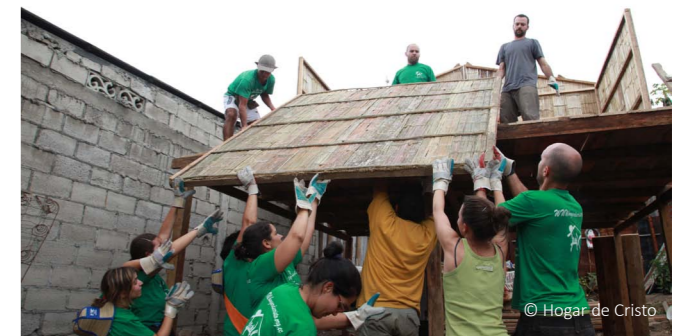
Armar una casa es muy rápido gracias al sistema de paneles prefabricados de caña picada con estructura de madera
