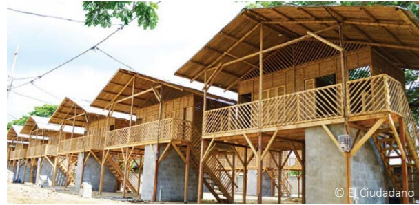
Viviendas formales de bajo costo evolución de las viviendas de transición, con servicios higiénicos y en terrenos viabilizados
