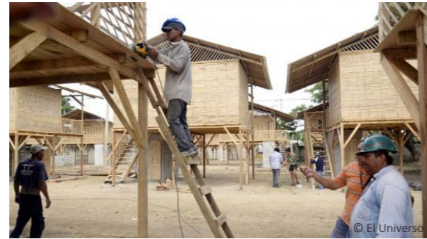
Viviendas mejoradas construidas con materiales locales
