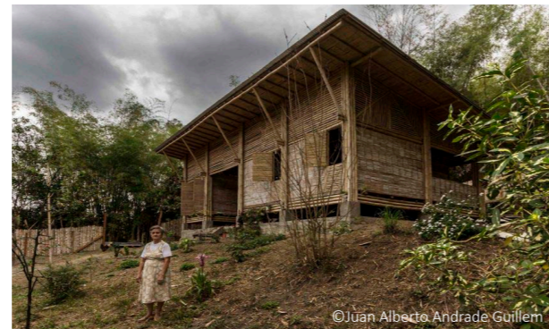
Vivienda contemporánea con materiales locales y mejoras constructivas en la parroquia Convento de Manabí
