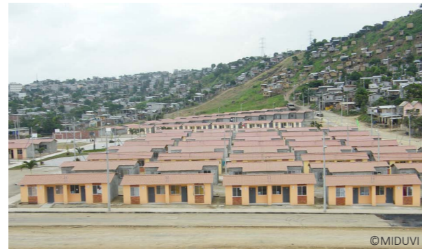
Viviendas construidas en terrenos viabilizados vs. viviendas irregulares en las lomas con riesgo en caso de corrimientos
