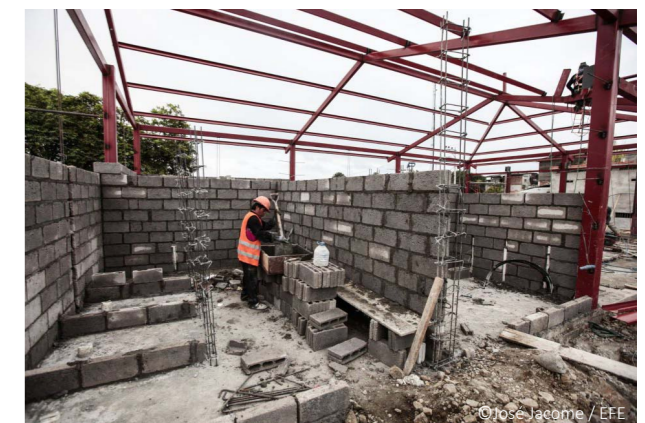
Reconstrucción de mercado en Pedernales tras terremoto
