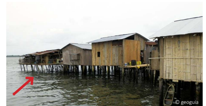
Estructura vertical sin arriostramiento genera falta de equilibrio
